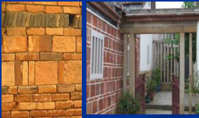
“出砖入石”材料原理的联想引用 材料组合工艺分析 图6-40 对闽南材料及工艺应用分析 (资料来源:作者手绘2010、6)
