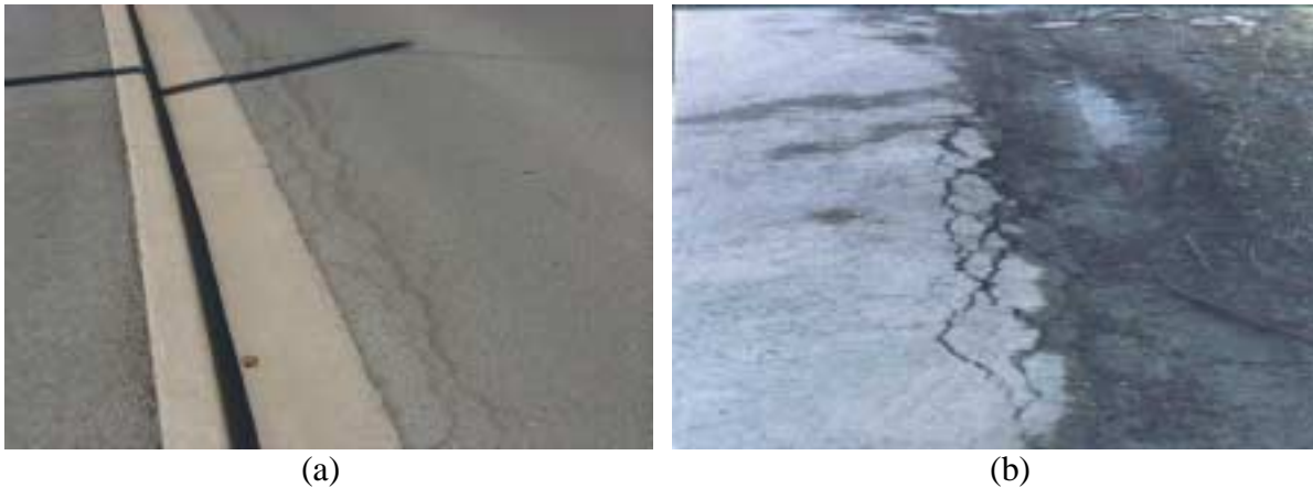
Figure D.2 Edge Cracking
